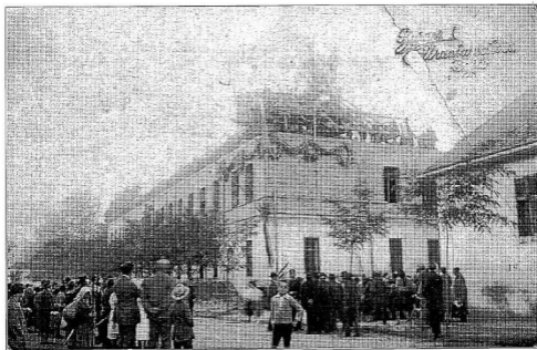
A mai Ganz gyár főépülete emeletráépítéskor (Vass Antal gyűjtése)
