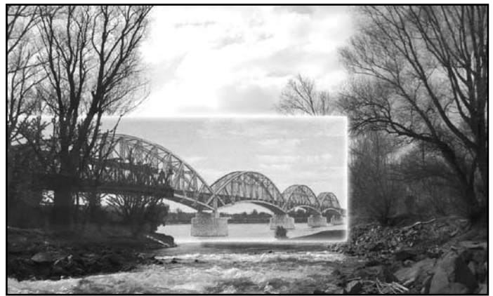
A Duna-híd és környezete
